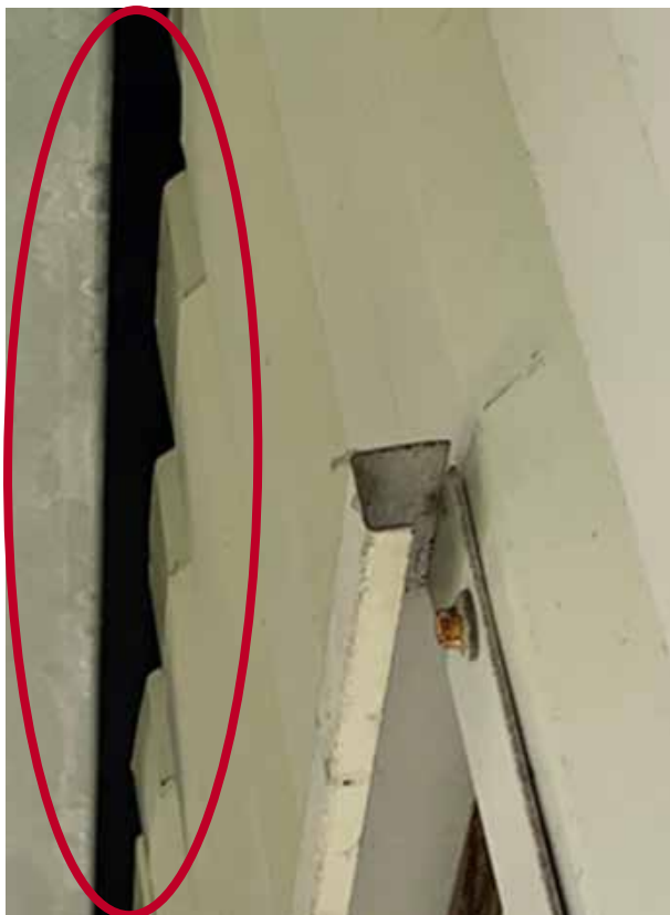
Afbeelding 5.4 Aansluiting tussen dakrand en gevel
