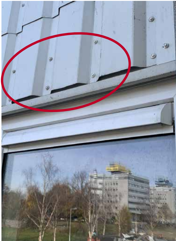
Afbeelding 5.3 Aansluiting gevelbeplating en kunststof raamkozijn
