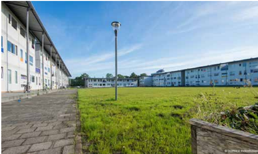
Afbeelding 3.3 Het binnenterrein, rechts blok 5 en 6
